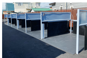
新たに増設した洗い場
