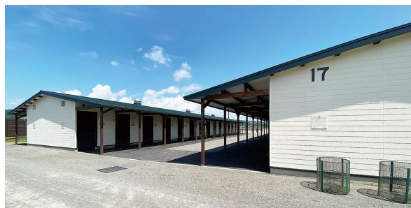
嵩上げ改修工事を行った厩舎
